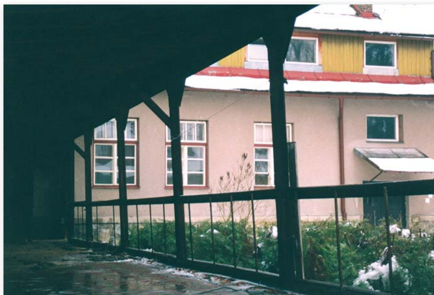
Stav posledních dochovaných leháren, řadu let však používaných jen jako spojovací chodba mezi Malinskými, těsně před zbouráním v roce 2001 (foto J.Jireš)
