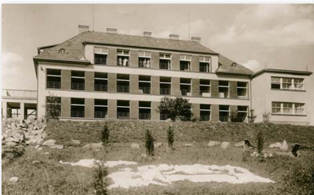
Osada před dostavbou v roce 1930 ve fázi dokončování (archiv)
