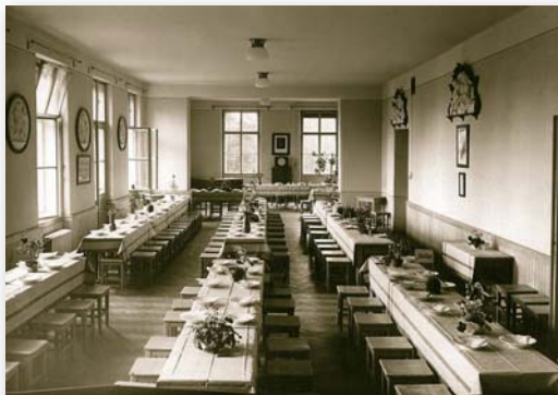
Jídelna v budově kuchyně, kde se ve třicátých letech stravovali všichni (archiv)
