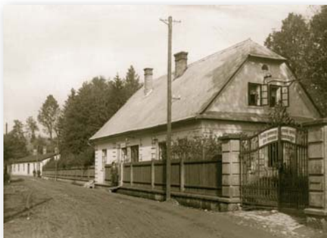
Původní vstup do sanatoria v r. 1905, v pozadí budova Dědeček (archiv)
